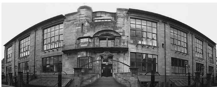
図 2 グラスゴー美術学校 (2014年5月の火災により現在修復中).
